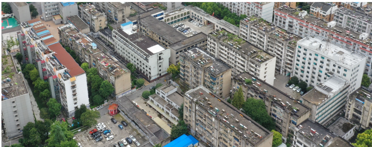
古城内部分建筑屋顶设施现状
