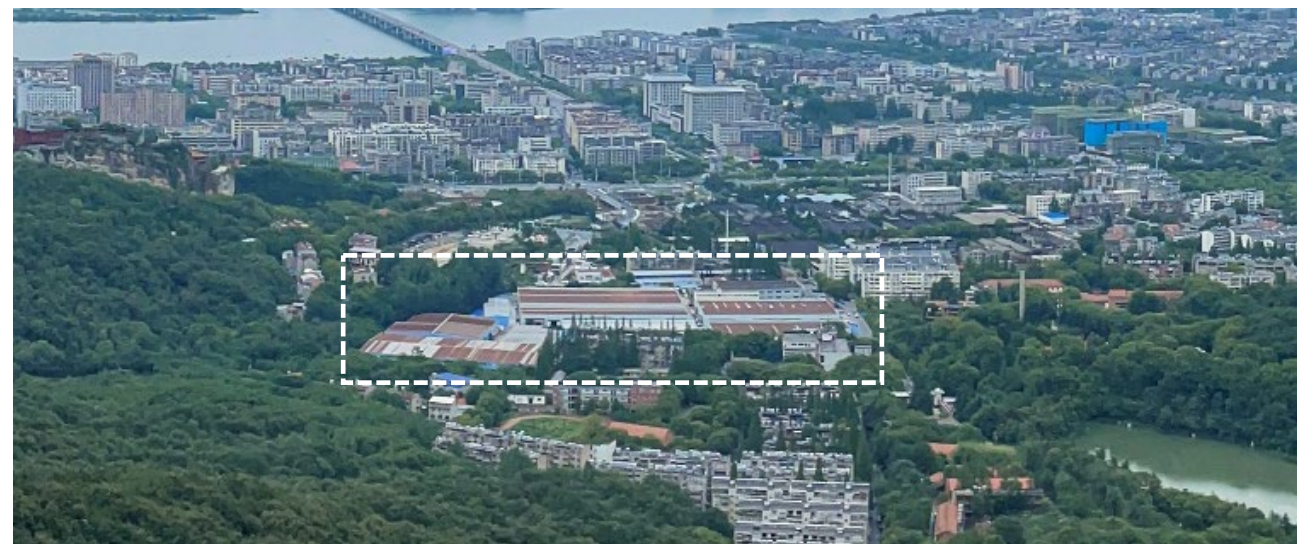
真武山工业园屋顶材质现状
